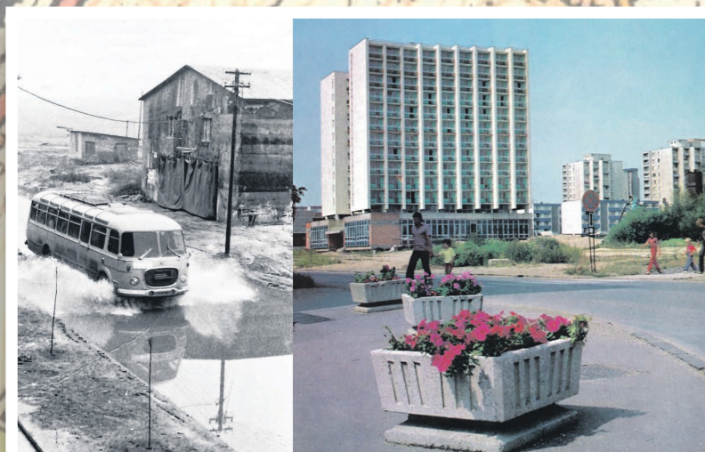
Vľavo: V roku 1961 betonárka a výroba malty. Vpravo: Približne v týchto miestach sa nachádzala bývalá betonárka.
