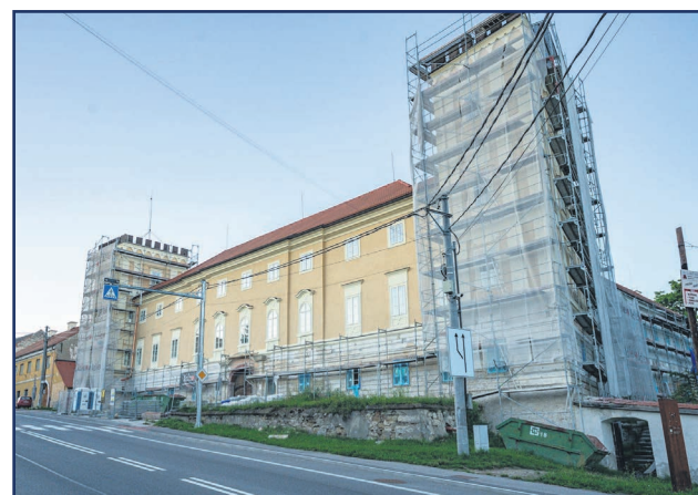
Rekonštrukčné práce na kaštieli pokračujú podľa plánu, obnoví sa aj priestor pred pamiatkou.
